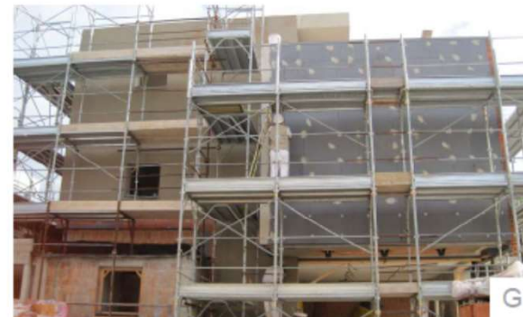
Rasatura armata del cappotto in EPS con graffite
