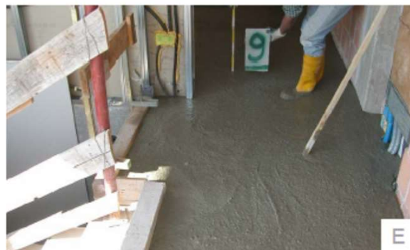
Spessore del calcestruzzo alleggerito (Isocal) del solaio al piano primo
