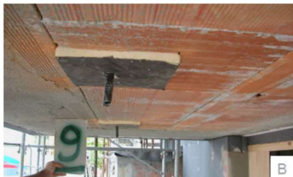
Isolamento dei faretti ad incasso sotto lo sbalzo del primo piano
