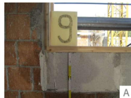
Spessore del calcestruzzo aerato (Ytong-Climaplus) sotto avanzato della parete in muratura
