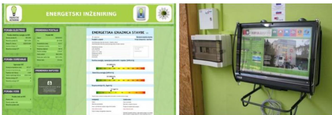
12. Ábra: Energetikai információs pont - bal oldalon a grafikus intrfész, job oldalon érintőképernyős kijelző látható
