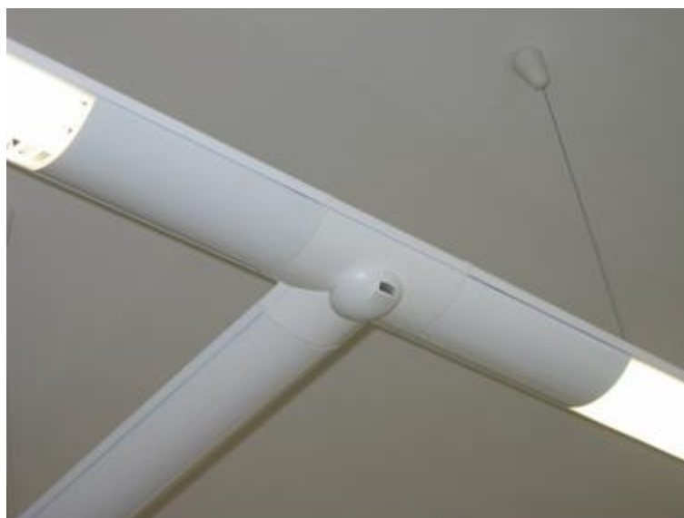
Slika 6.7: Sodobna fluorescentna razsvetljava z nadzorno funkcijo DALI
