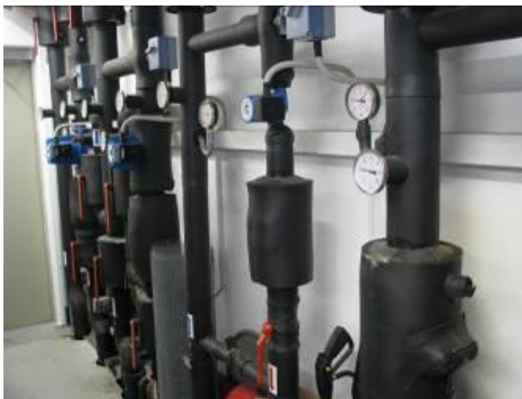
Slika 6.5: Sodobni razdelilnik tople vode
