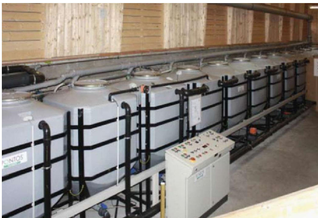
Slika 12: Višestupanjski reaktor s pokretnim nosačima (MBBR) za recikliranje sive vode u stambenoj zgradi (fotografija: E. Nolde).
