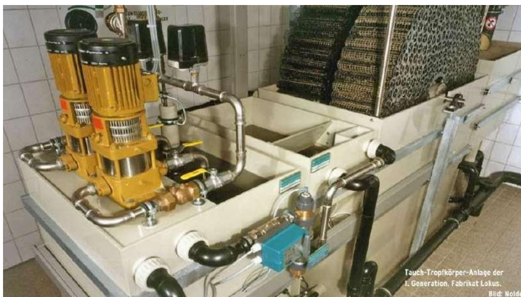
Slika 11: Rotirajući biološki kontaktori (RBC) u višekatnici. Sustav prve generacije za recikliranje sive vode iz 1995. godine (fotografija: E. Nolde).
