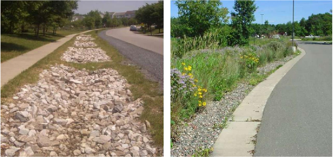
Slika 40: Primjeri rovova za infiltraciju. 39
