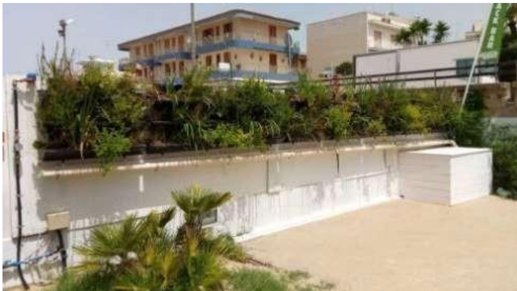
Slika 19: Zeleni zid za ponovnu upotrebu pročišćene sive vode u vrtu, plaža Margarita, Marina di Ragusa (RG - Italija). 45
