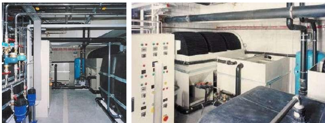
Slika 28: Sustav za recikliranje sive vode sa 6 RBC modula i spremnikom za naknadnu sedimentaciju.
