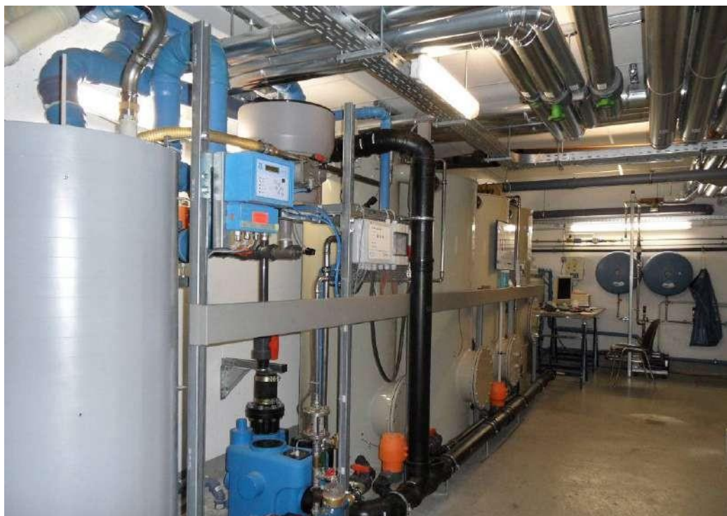
Slika 24: Sustav recikliranja sive vode uključujući uporabu topline iz sive vode u podrumu zgrade.
