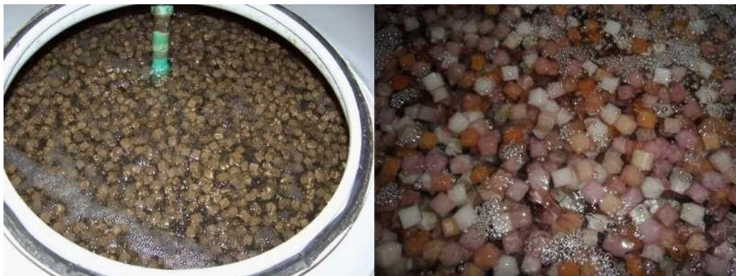
Slika 13: Reaktor s prozračenim pokretnim nosačima biofilma (MBBR) (lijevo) i pjenaste kocke kao nosač (fotografija: E. Nolde).
