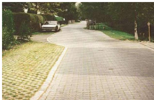
Popločavanje s otvorenim fugama (prazninama) i travnatim elementima za popločavanje za parkiranje automobila
