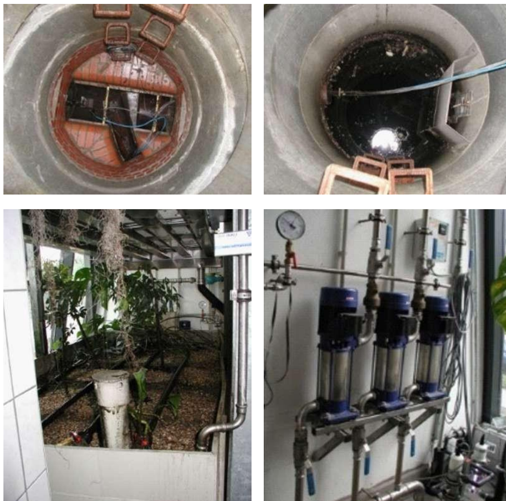
Slika 47: Oborinska kanalizacija sa skretnicom (gore) i filter zasadene zemlje unutar zgrade (dolje).
