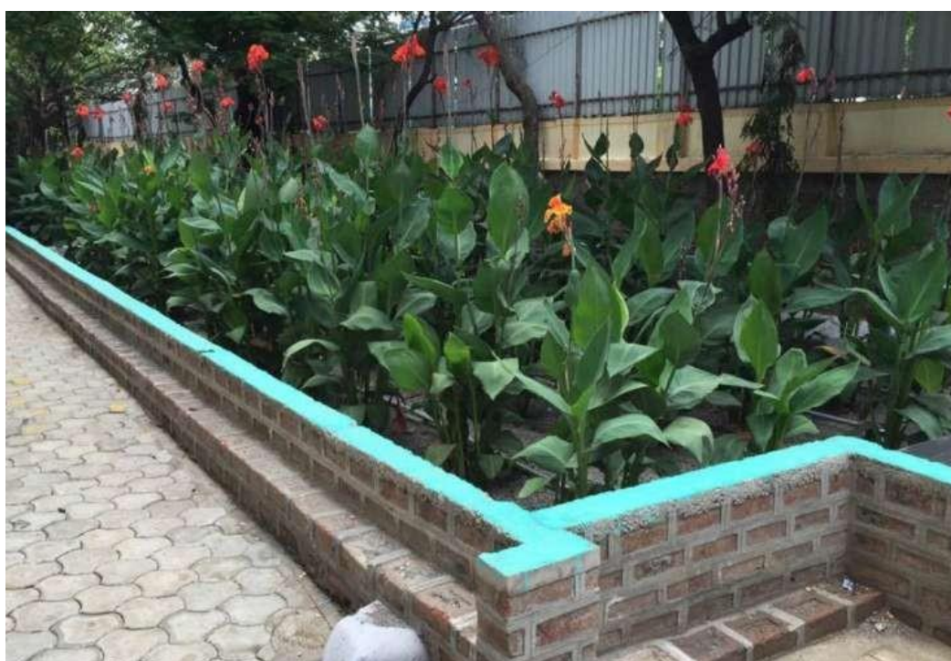
Slika 18: VF sustav za odvajanje, pročišćavanje i ponovnu upotrebu sive vode za ispiranje WC-a u Hostelu kampusa Fakulteta za inženjering, Pune (Indija). 45
