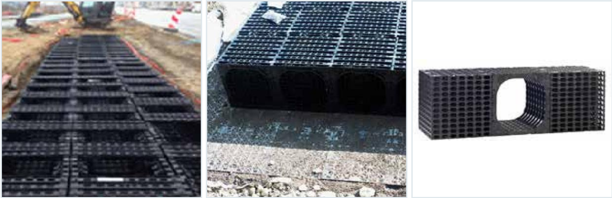
43. ábra: Árokelemek (beszivárogató dobozok) füvesített árok-beszivárogató blokk rendszerekhez (ENREGIS).
