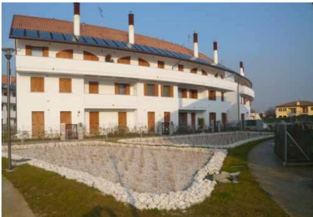
17. ábra: HF rendszer a szürkevíz szétválasztására, kezelésére és újrafelhasználására WC-öblítéshez Preganziol (TV - Olaszország) 45 .
