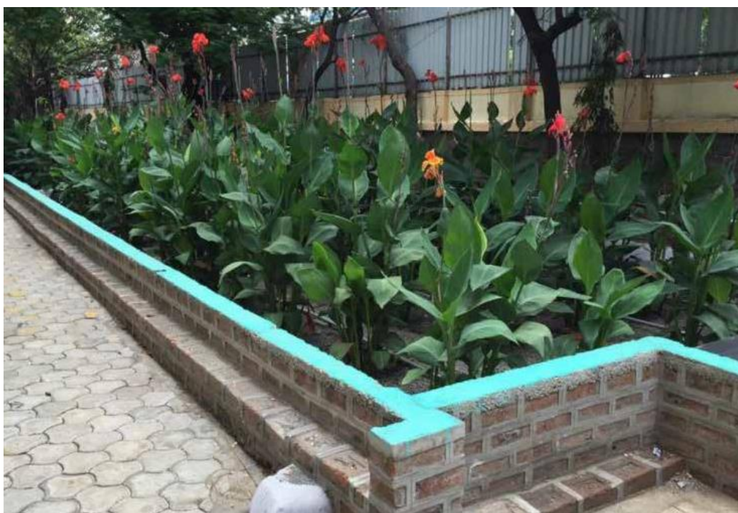
18. ábra: VF rendszer a szürkevíz elválasztására, kezelésére és újrafelhasználására WC-öblítéshez a mérnöki főiskola egyik kollégiumában, Pune (India) 45 .
