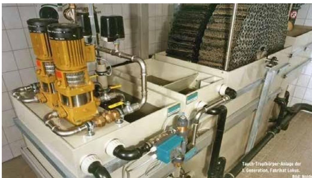
11. ábra: Forgó biológiai kontaktorok (RBC) egy többszintes épületben. Első generációs rendszer a szürkevíz újrahasznosítására 1995-ből (Fotó: E. Nolde).
