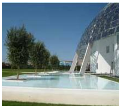
29. ábra: Keracoll „GreenLab” képe (fent), nyitott víztartály és esőkert (lent). Forrás: Bios IS Srl ( www.bios-is.it ) és IRIDRA Srl ( www.iridra.com ).
