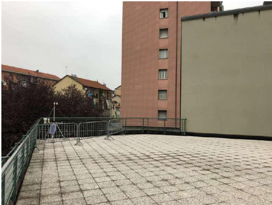
Figura 4: La terrazza vista da Ovest, prima dell'inizio dei lavori
