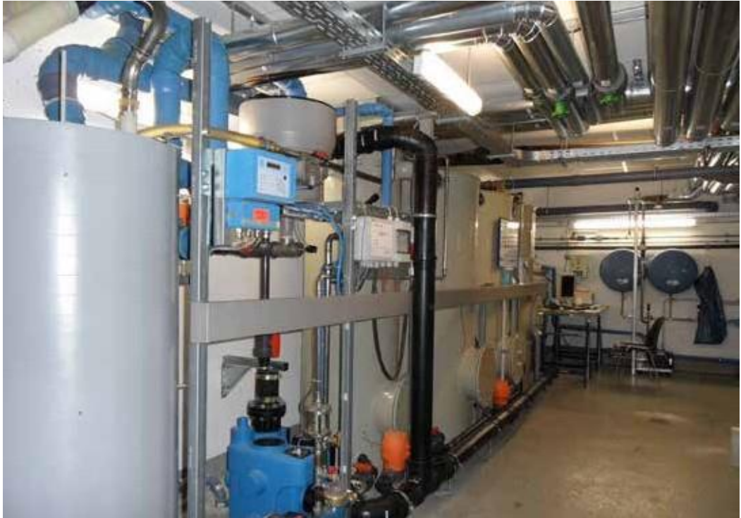
Figura 9: il sistema di riciclaggio delle acque grigie e recupero del calore, nelle cantine dell'edificio
