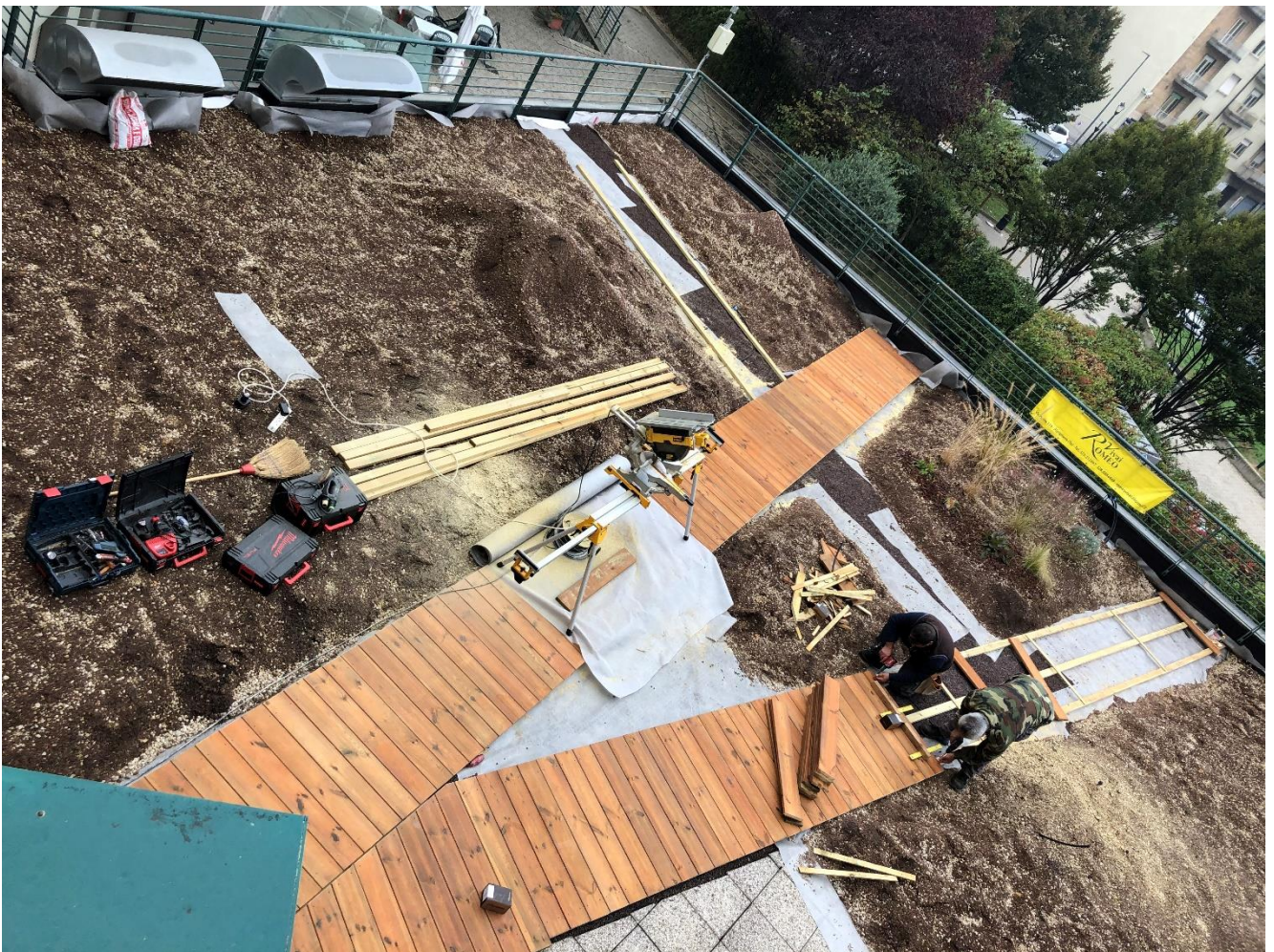
Figura 6: Diverse fasi di realizzazione della terrazza
