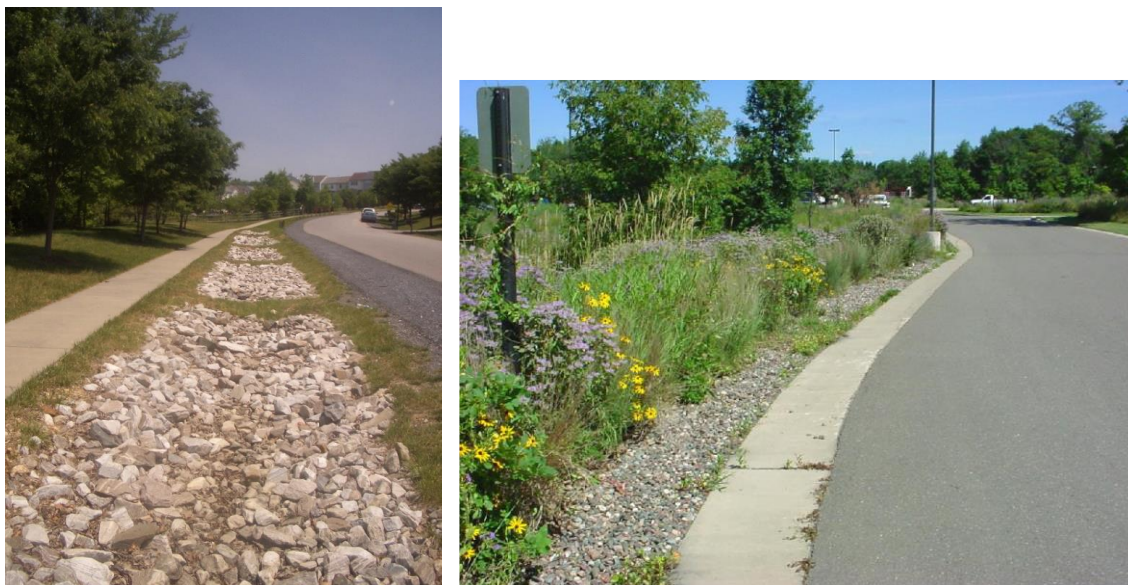
Figura 19 - due esempi di trincee di infiltrazione. Fonti: https://sustainablestormwater.org/2007/05/23/infiltration-trenches/ e https://stormwater.pca.state.mn.us/index.php/Main_Page
