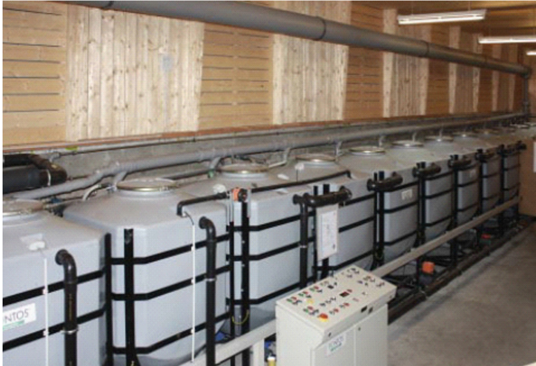
Rysunek 12: Wielostopniowy reaktor z ruchomym złożem biologicznym (MBBR) do recyklingu szarej wody w budynku mieszkalnym (Fot: E. Nolde).
