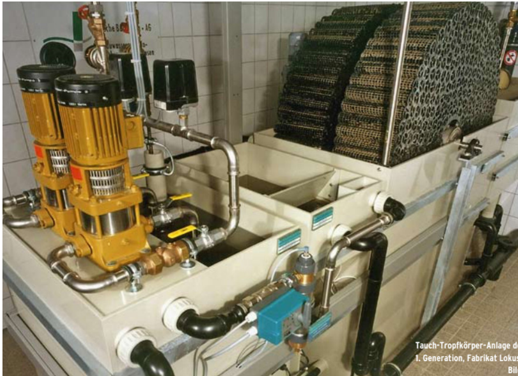
Rysunek 11: Obrótowe złoża biologiczne w budynku wielopiętrowym. System pierwszej generacji do recyklingu wody szarej z 1995 roku (fot: E. Nolde).
