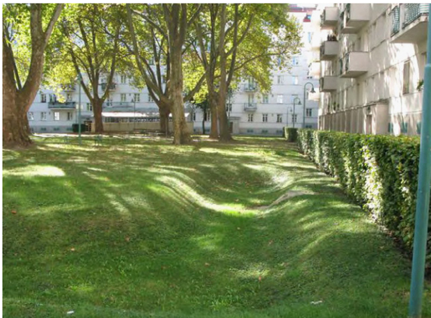
Rysunek 36: Muldy chłonne na terenach mieszkalnych (Sieker).
