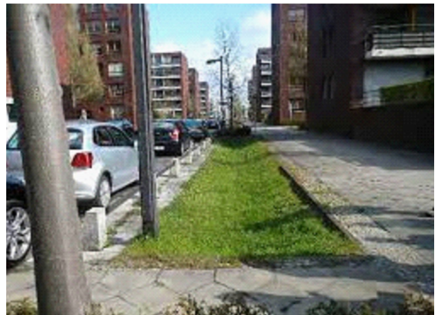
Rysunek 36: Muldy chłonne na terenach mieszkalnych (Sieker).
