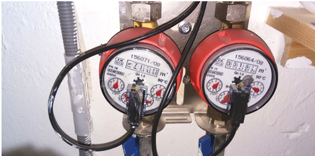
Rysunek: Inteligentne wodomierze zainstalowane w mieszkaniach
