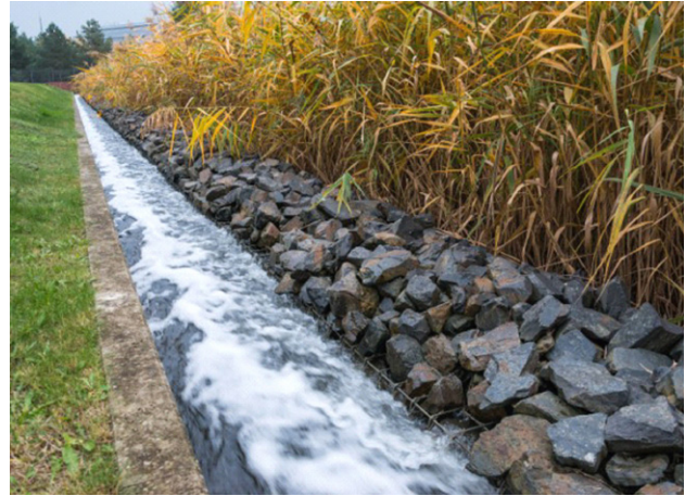
Rysunek 25: Oczyszczalnie hydrofitowe z przepływem pionowym w Berlinie (Fot: Andreas Süß).
