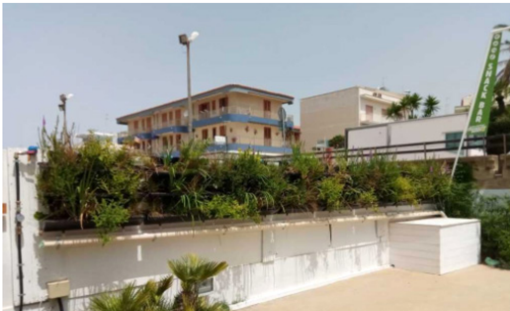
Rysunek 19: Zielona ściana na cele ponownego wykorzystania oczyszczonej szarej wody w ogrodnictwie, plaża Margarita, Marina di Ragusa (RG - Włochy) 45 .
