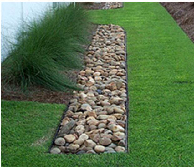
Rysunek 41: Rów infiltracyjny z połączeniem do dachu 40 .
