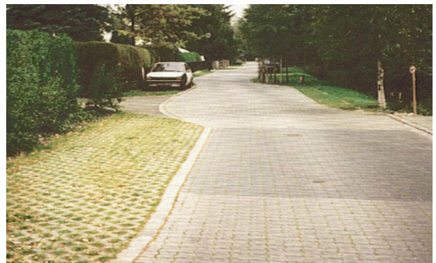
Nawierzchnia z otwartą fugą (szczelinami) i betonowe płyty ażurowe na miejscach postojowych
