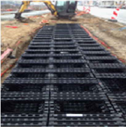
Rysunek 43: Elementy rowów (skrzynki rozsączające) dla systemów mieszanych mulda chłonna+row infiltracyjny (ENREGIS).
