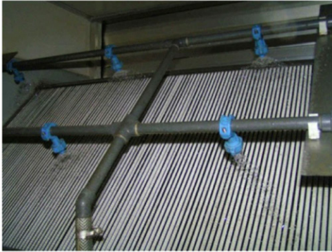
Adiabatyczne chłodzenie powietrza wywiewanego, Instytut Fizyki na Uniwersytecie Humboldtów, Adlershof, Berlin (Foto: M. Schmidt).
