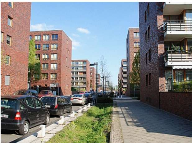
Rysunek 44: Systemy mieszane mulda chłonna+row infiltracyjny w Berlinie (Sieker).
