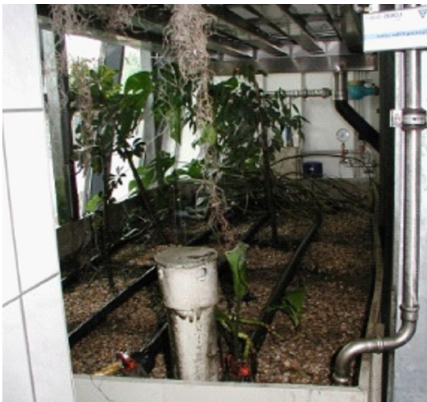
Rysunek 47: Kanalizacja deszczowa z odprowadzeniem (powyżej) i oczyszczalnia hydrofitowa z nasadzeniami wewnątrz budynku (poniżej).
