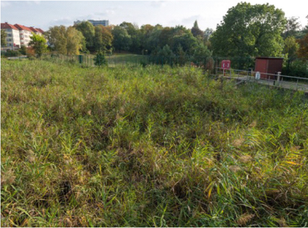
Rysunek 25: Oczyszczalnie hydrofitowe z przepływem pionowym w Berlinie (Fot: Andreas Süß).
