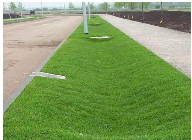
Rysunek 44: Systemy mieszane mulda chłonna+row infiltracyjny w Berlinie (Sieker).
