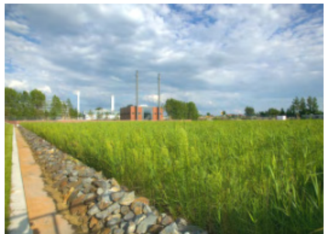
Rysunek 56: Oczyszczalnia hydrofitowa z przepływem pionowym w Berlinie-Adlershof (Źródło: BWB).
