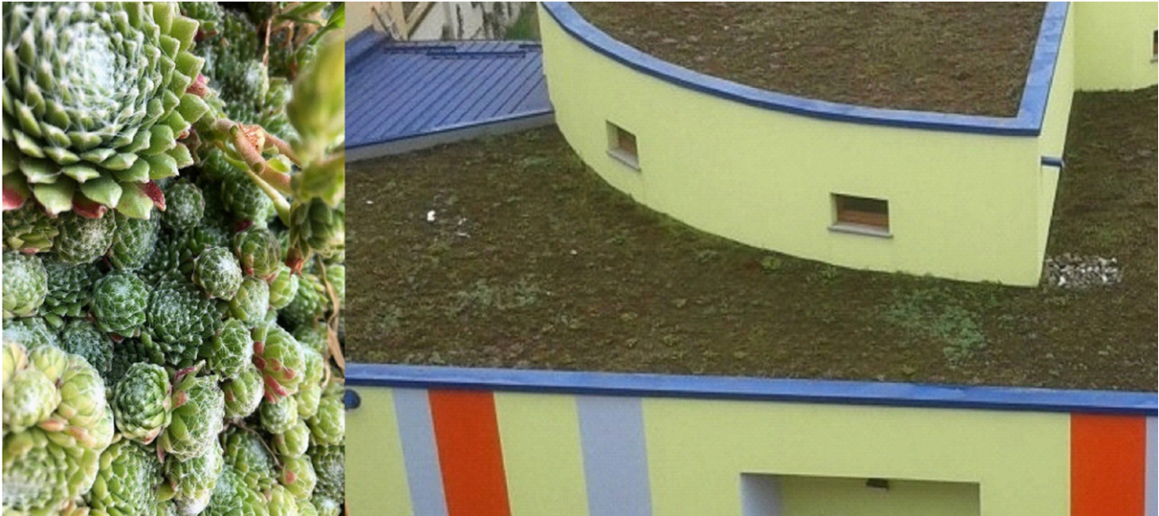
Rysunek 14: Ekstensywny zielony dach - rozchodnik, rojnik - park rozrywki dla dzieci Paguro, Turyn (fot: A. Aires).
