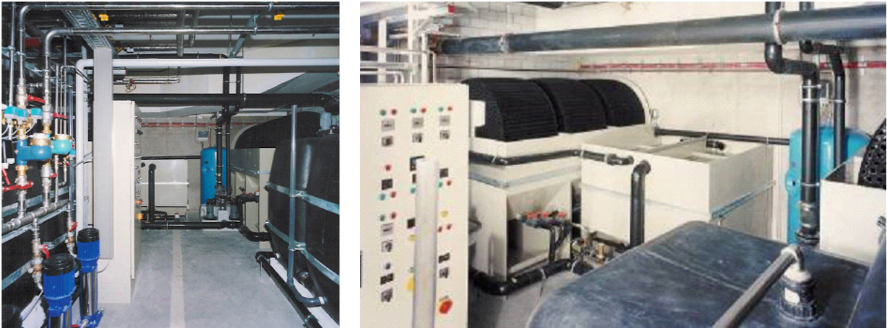
Rysunek 28: System recyklingu szarej wody z 6 modułami RBC i osadnikiem wtórnym.
