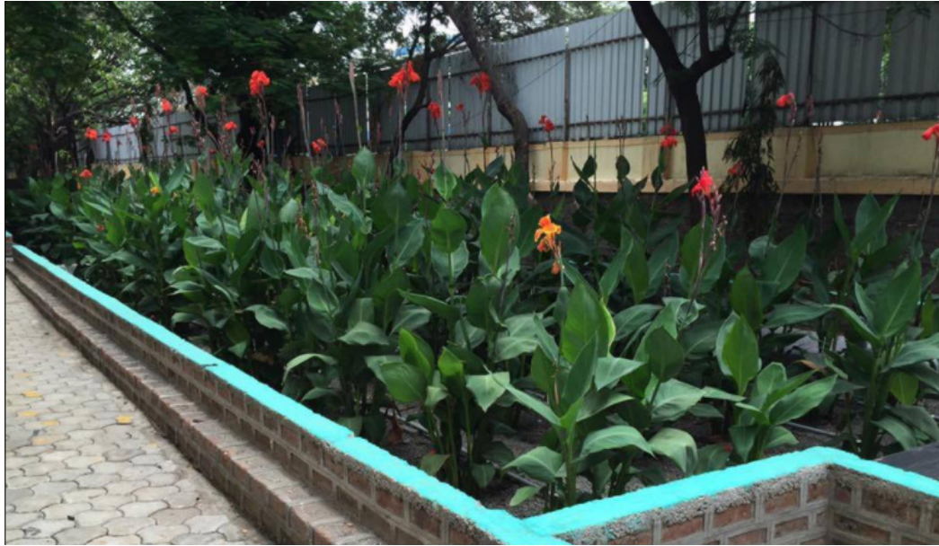
Rysunek 18: System z przepływem pionowym do oddzielania, oczyszczania i ponownego wykorzystania szarej wody do sputkiwania toalet na terenie kampusu politechniki, Pune (Indie) 45 .
