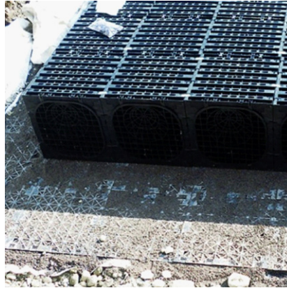
Rysunek 43: Elementy rowów (skrzynki rozsączające) dla systemów mieszanych mulda chłonna+row infiltracyjny (ENREGIS).
