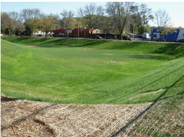
Rysunek 27: Polder przeciwpowodziowy w okresach suchych i mokrych 34 .
