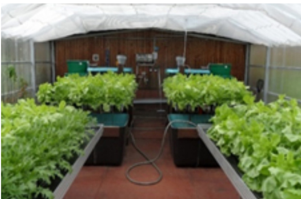
Rysunek 22: Miejskie systemy akwaponiczne i hydroponiczne wykorzystujące oczyszczoną szarą wodę i ścieki w projekcie Block 6.
