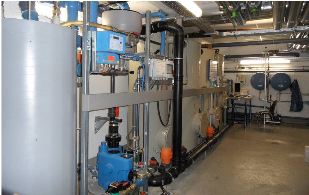
Rysunek 24: System recyklingu wody szarej, w tym odzysk ciepła z wody szarej w piwnicy budynku.
