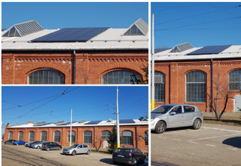
Slika 12: Fotonapetostna naprava na strehi tramvajskega depoja MPK Vroclav (avtor fotografije: Marcin Wolek)
