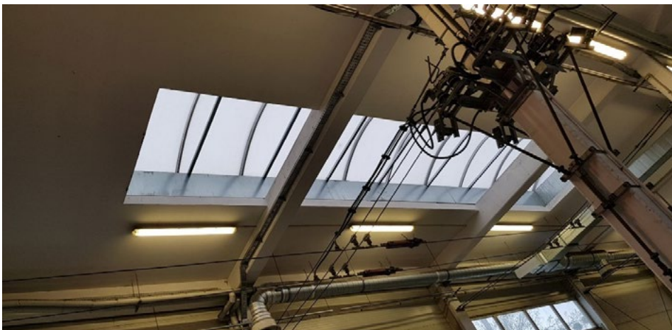
Abbildung 11: Erneuerung der Dachoberlichter im Depot von PKT Gdynia (Foto von Marcin Wolek)
