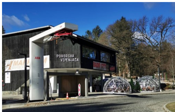
Slika 4: Brzi punjač za e-autobuse na postaji žičare (Općina Maribor)
