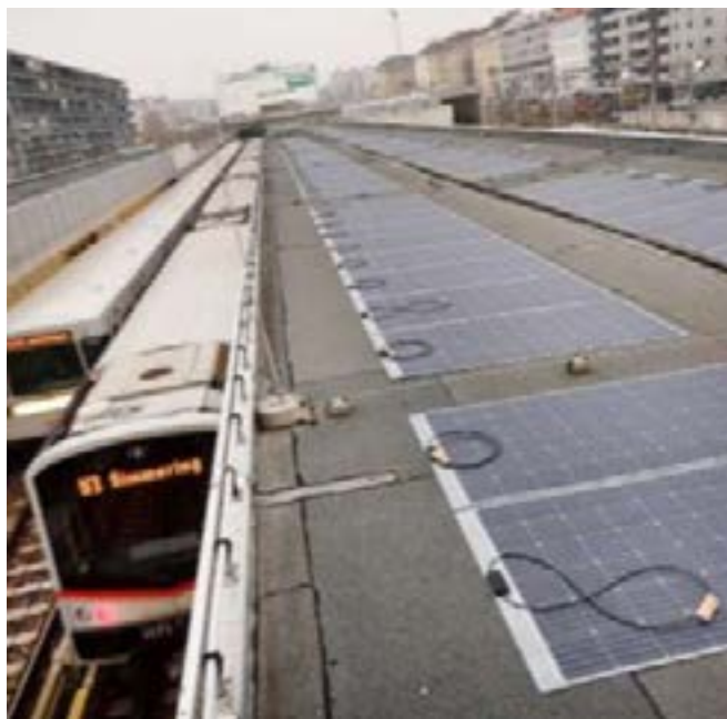
Slika 8: Fotonapetostne folije na strehi postaje podzemne železnice (Wiener Linien)
