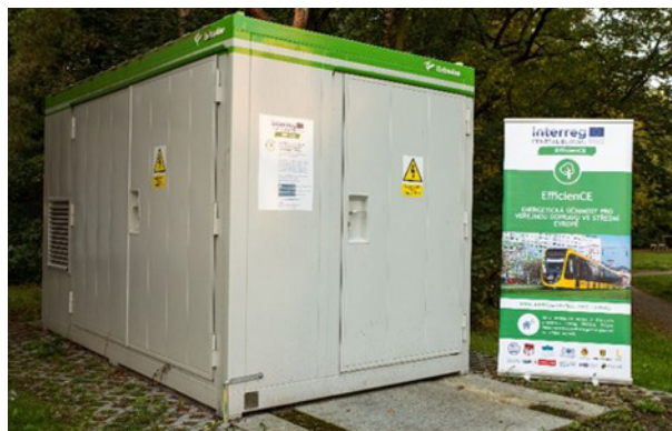
Slika 5: Akumulatorska stanica međupohrane u Plzňu (PMDP)
