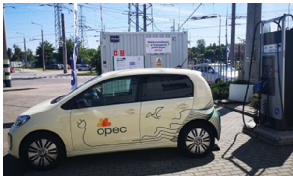
Slika 6: Mobilna stanica za punjenje za električne automobile koju napaja mreža trolejbusa (PKT)
