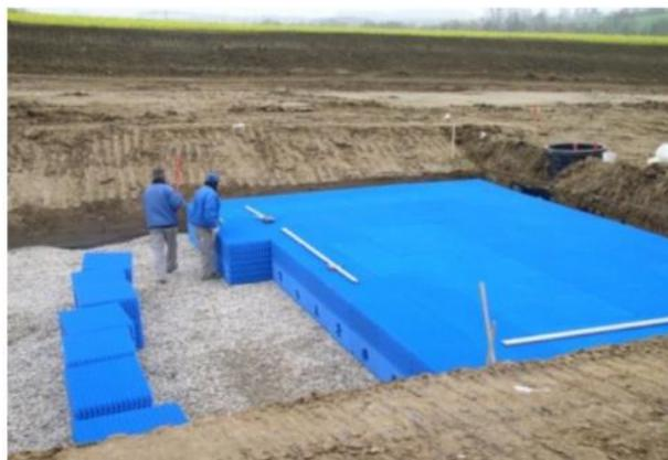
Installazione di una trincea di infiltrazione con materiale di riempimento (Photo: Sieker)
