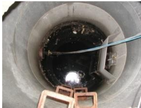
Kanalizacja deszczowa z przetącnikiem kierunkowym
