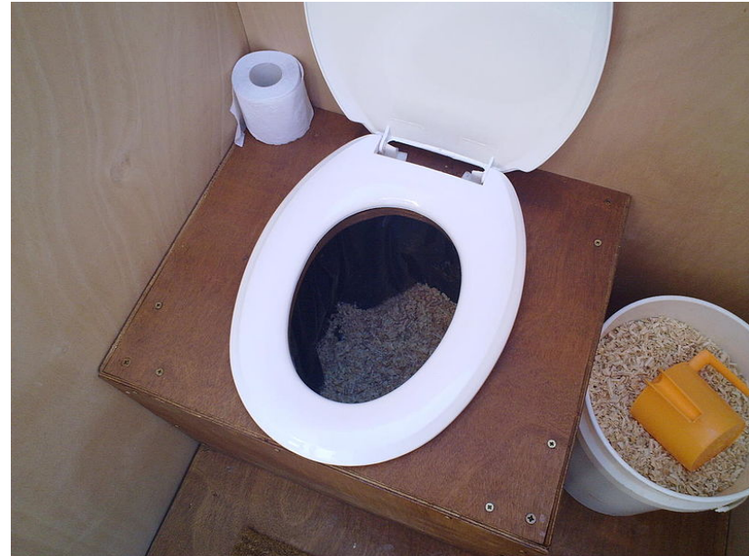
Zahodske školjke s kompostiranjem uz korištenje piljevine (bezvodne)
