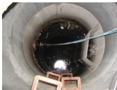
Kanalizacija deževnice s stikalom za preusmeritev
