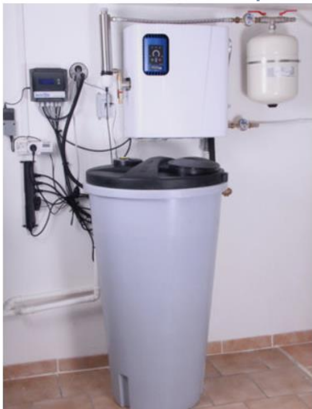
Zbiralnik za čisto vodo z Rainmaster Favorit SC, AQUALOOP kontrolnim sistemom in UV dezinfekcijo
