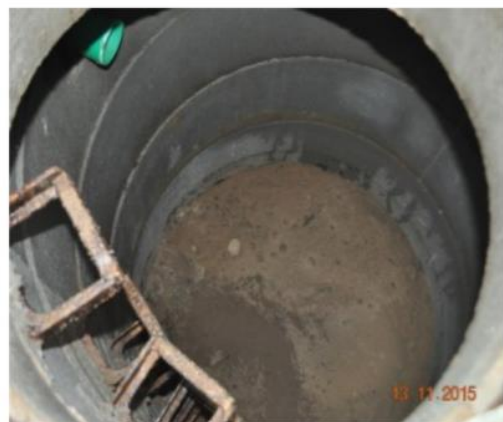
Pogled na dno namakalnika - soakaway (Fotografija: Sieker)
