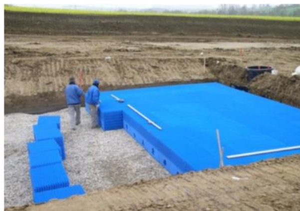
Postavitev infiltracijskega jarka s polnilnim materialom (Fotografija: Sieker)
