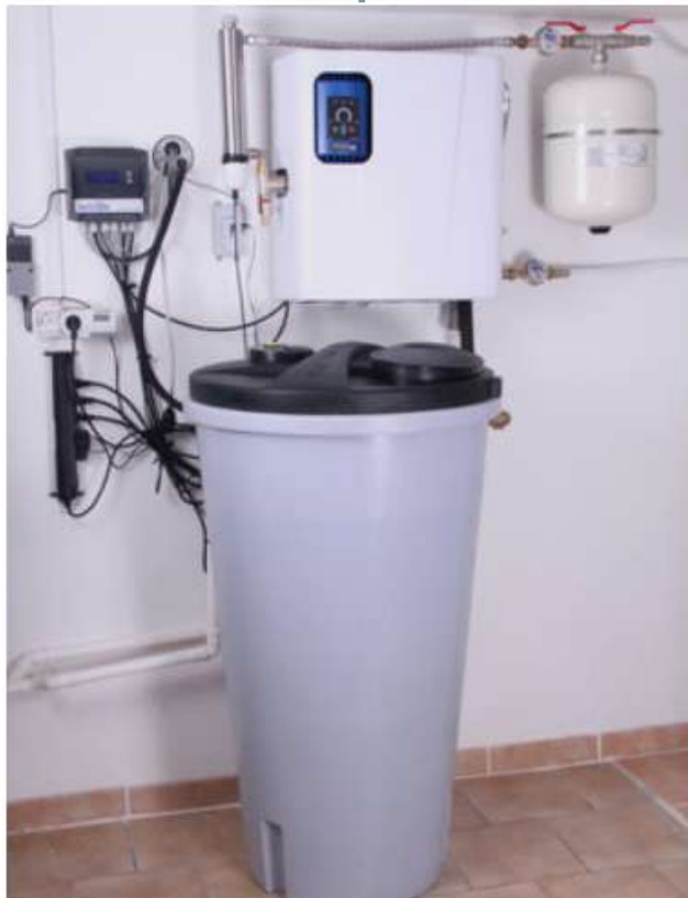
Spremnik s bistrom vodom s Rainmaster Favorit SC, AQUALOOP kontrolnim sustavom i UV dezinfekcijom
