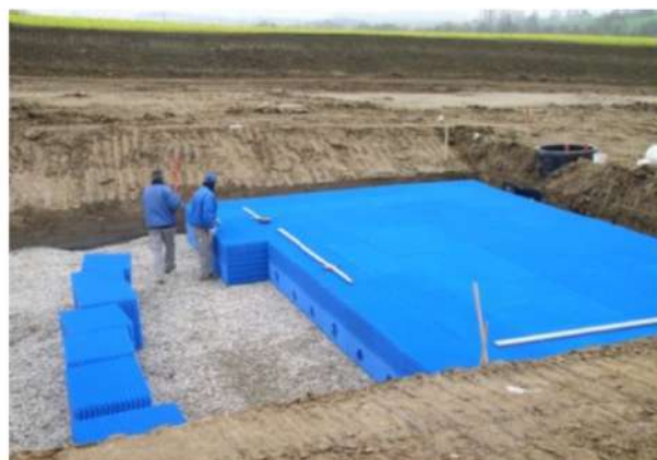
Postavljanje infiltracijskog rova s materijalom za punjenje (Foto: Sieker)
