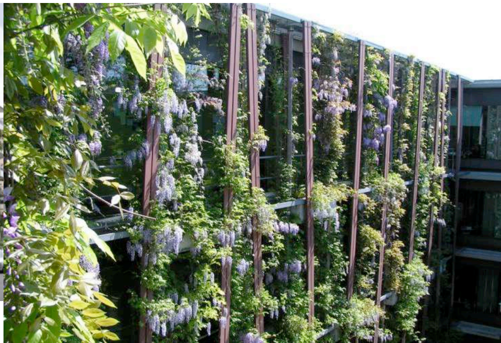
Povezani sustav ozelenjavanja fasada u spremnicima, institut za fiziku u Berlinu Adlershof (Foto: M. Schmidt)
