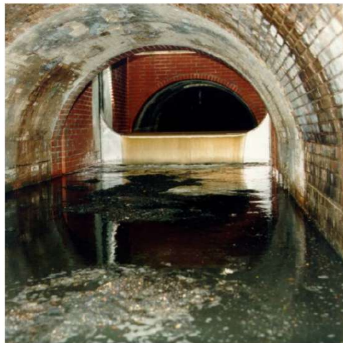
Zapornica preko koje se preljeva voda u dodatni prostor za retenciju, Berlinu-Wedding (Foto: BWB)
