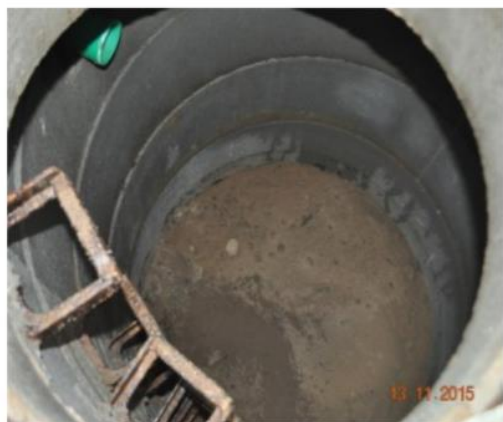
Widok dna studni chłonnej (Zdjęcie: Sieker)
