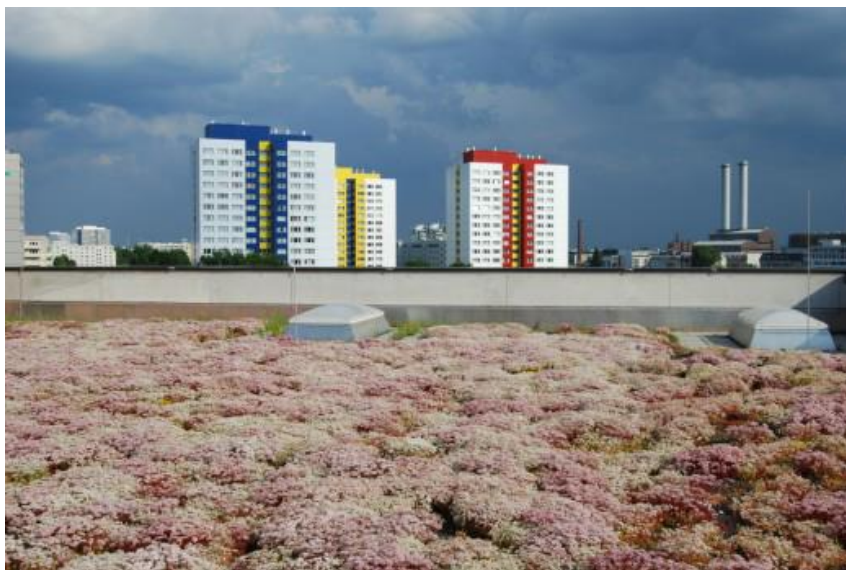
Rozległy zielony dach, Alexa, Berlin (Zdjęcie: FBB, G. Mann)
