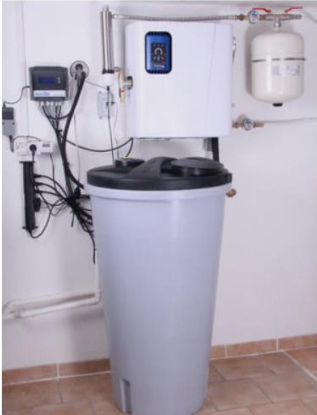
Zbiornik na czystą wodę Rainmaster Favorit SC, system kontroli i dezynfekcji UV AQUALOOP
