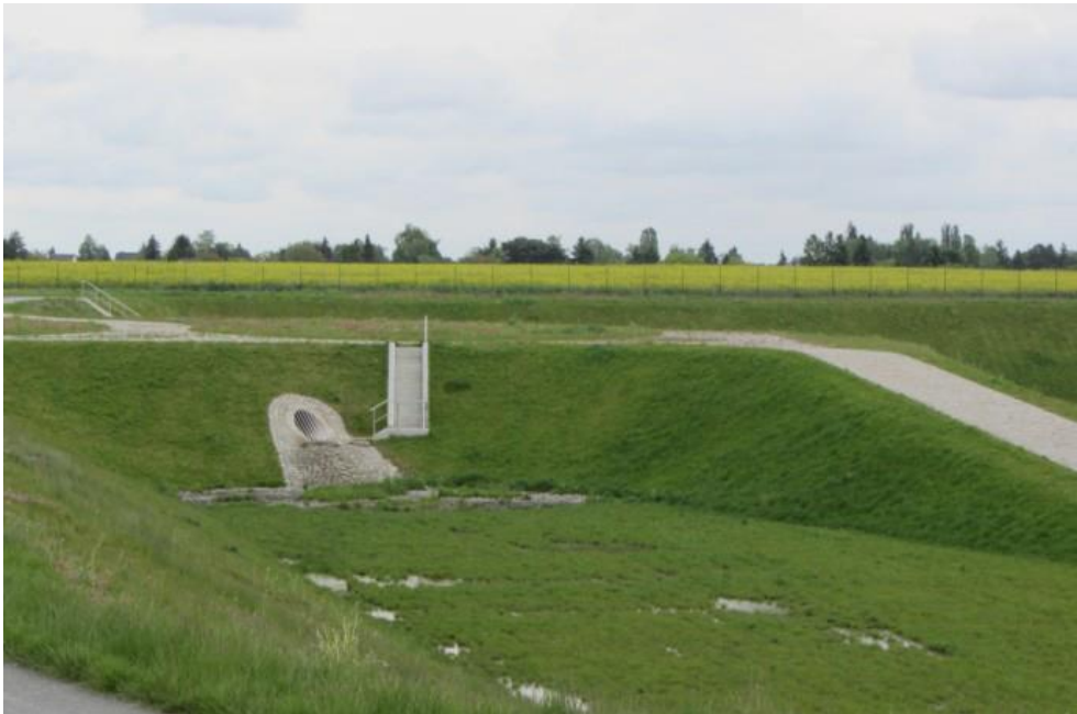
Zbiornik retencyjny wody deszczowej w Biznes Parku Berlin-Bohnsdorf (Zdjęcie: BWB)
