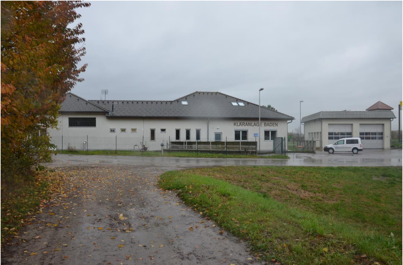
Abbildung 21: Die Kläranlage in Baden © KBÖ
