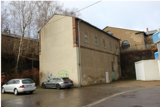
Abb. 15: ehem. Trockenpochwerk (Foto: M. Hanke)
