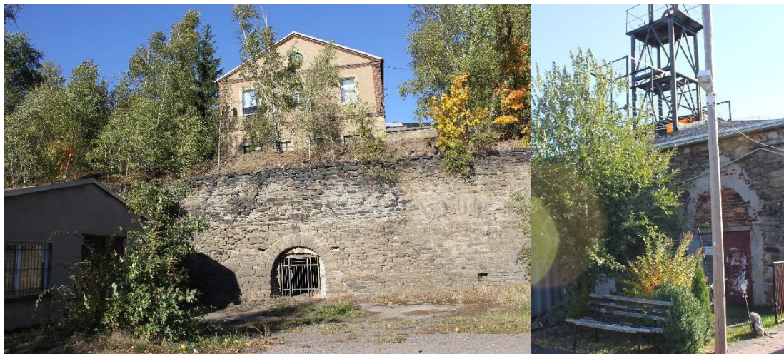
Abb. 17 u. 18: ehem. Scheidebank, Mundloch und Fördergerüst Turmhofschacht (Fotos: M. Hanke)
