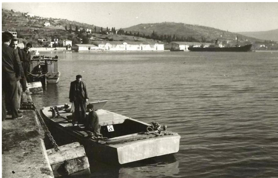
Slika 9: Pogled na Monfort in Grando. Zahodna kampata Monforta je že znižana, vzhodnega prizidka pa še ni. (vir
