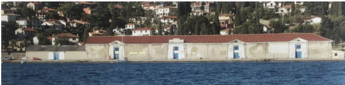
Slika 3: Skladišče soli; pogled na objekt Monfort z morja
