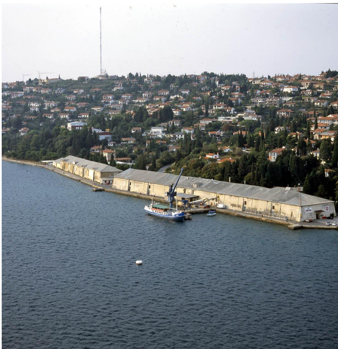
Slika 1: pogled na skladišči Grando in Monfort (pred letom 2014)
