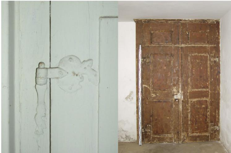
**Abb.: 104** wertvolle barocke Türbeschläge (links) und Innenelement der Eingangstür aus der ersten Hälfte des 19. Jh. (rechts)<sup>218</sup>
