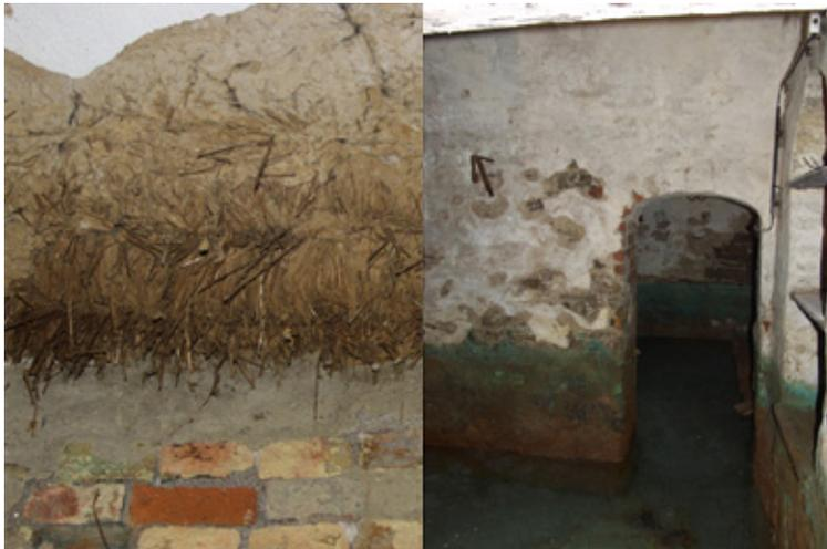
**Abb.: 106** schwere Feuchteschäden an der Lehmfelderdecke des EG (links) und stehendes Wasser in den Kellerräumen (rechts)<sup>220</sup>
