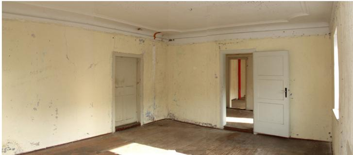
**Abb.: 102** Der barocke Eckraum im Obergeschoss des Huthauses mit zeittypischer Stuckdecke, Türblatt und Dielenboden<sup>216</sup>
