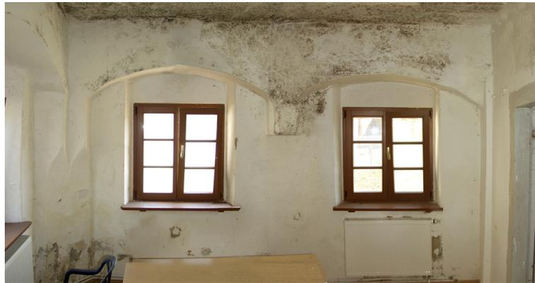
**Abb.: 101** Die Fensterarchitektur des 17. Jh. an der nördliche Außenwand des Erdgeschosses, die Mittelkonsole ist im 17. Jh. ein typisches Architekturelement in Freiberg<sup>215</sup>
