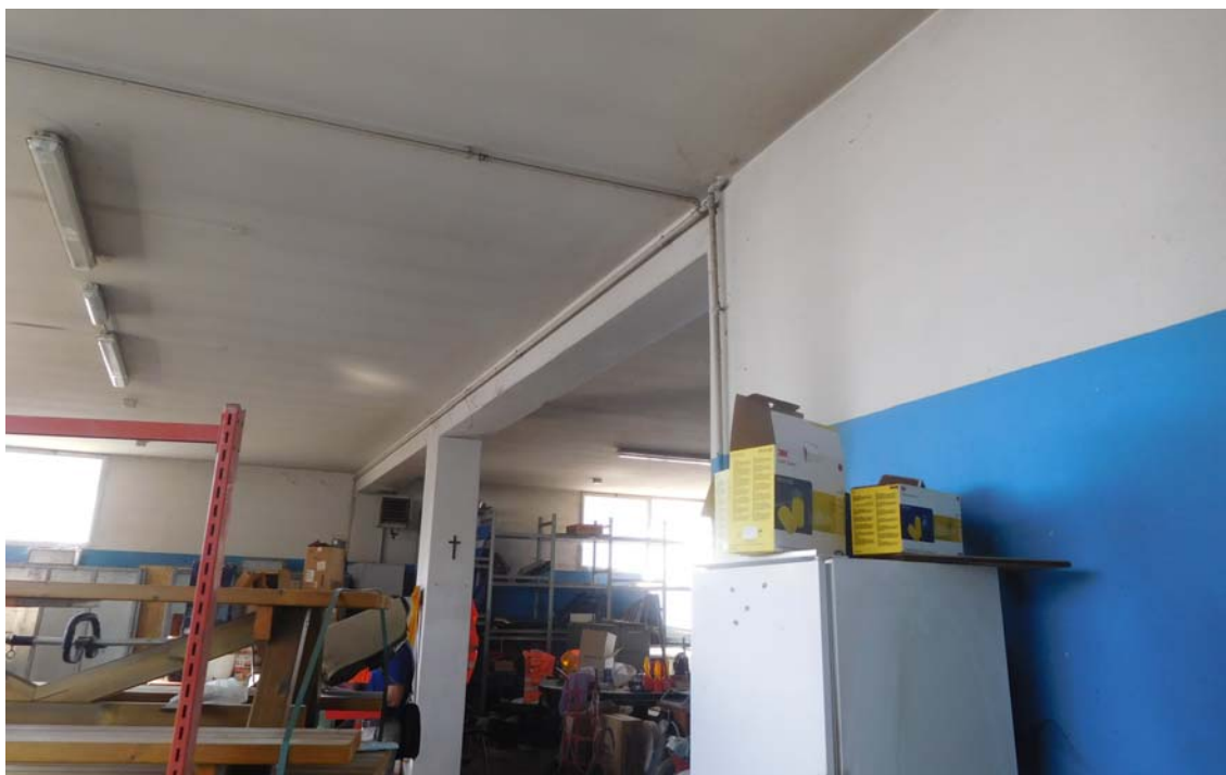
Foto 6: Vista generale officina da riqualificare
