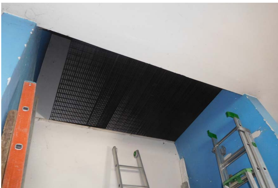
Foto 9: l'ex vano ascensore da chiudere
