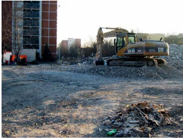
Bild 1 (links): Fläche nach Abriss eines Hochhauses im Jahr 2006. © R. Bendner
