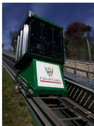
Sistema FV + batteria (Cuneo, IT)
