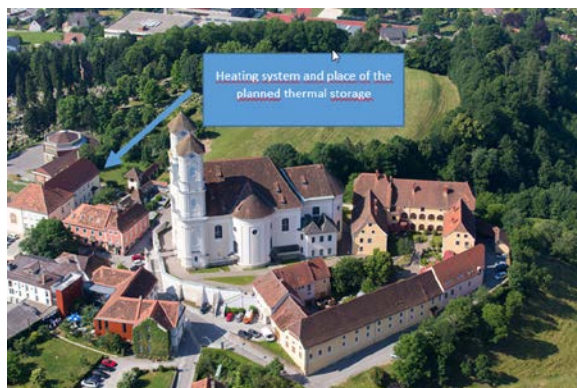
Accumulo di energia termica per il riscaldamento (Weiz, AT)
