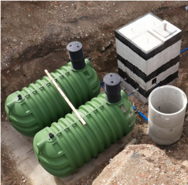
Unterirdische Speicher für Regenwasser und gereinigtes Abwasser. Foto: Aleš Erker, MBVOD.
