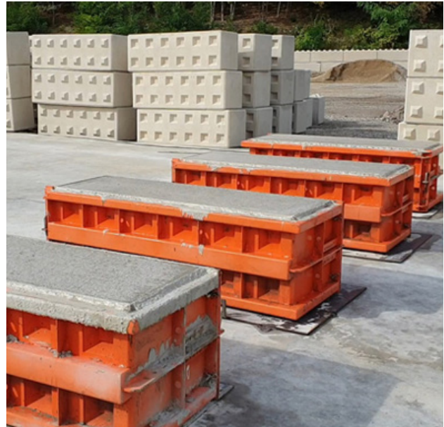
Aus recyceltem Wasser hergestellte Betonblöcke (CWC and Cinderella Projekte). Foto: Aleš Erker, MBVOD.
