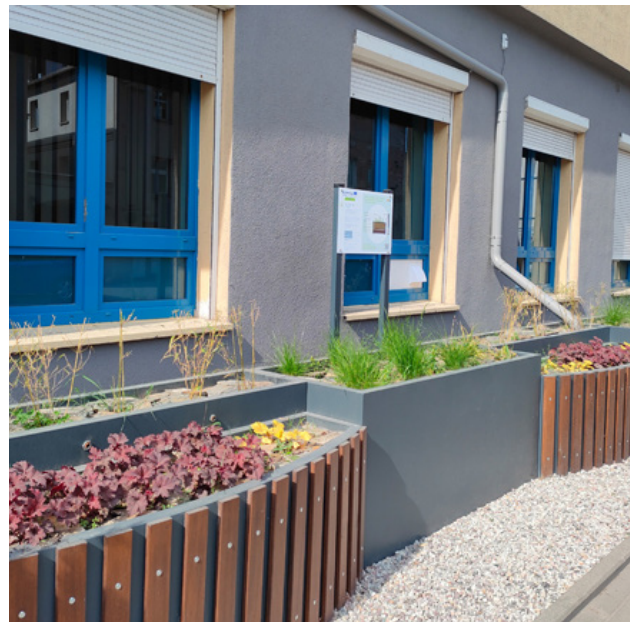
Rain garden in containers at Bydgoszcz City Hall, Grudziądzka Street. Photo: B. Katarzyna Napierała, City of Bydgoszcz.
