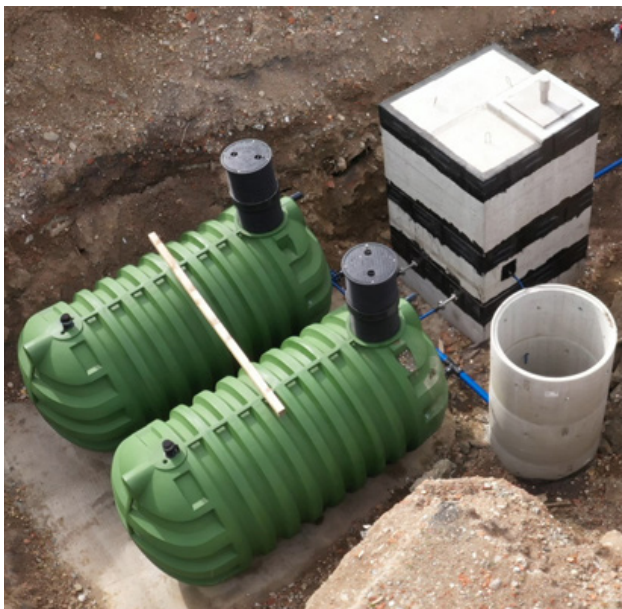
grada pilot postrojenja. Fotografija: Aleš Erker, MBVOD.
