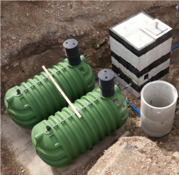
Budowa pilotażowej instalacji (zbiorniki na deszczówkę i oczyszczone ścieki). Fot. Aleš Erker, MBVOD.
