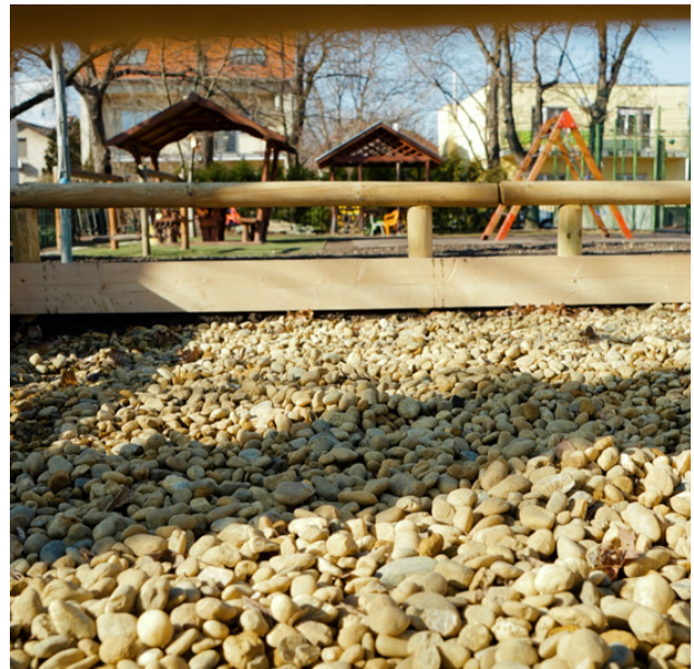
Żwirowa warstwa filtracyjna. Fot.: Dzielnica Zugló.
