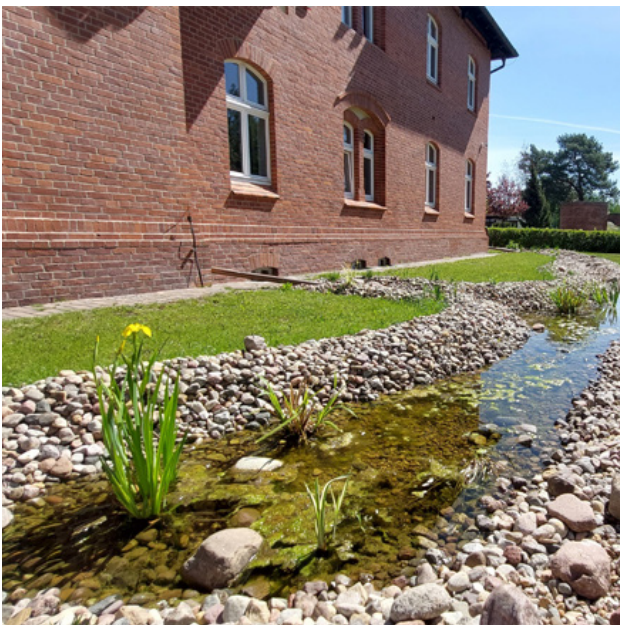
Deževni vrtovi v Muzeju vodovoda, Jacek Cieściński, Bydgoszcz Municipal Waterworks.
